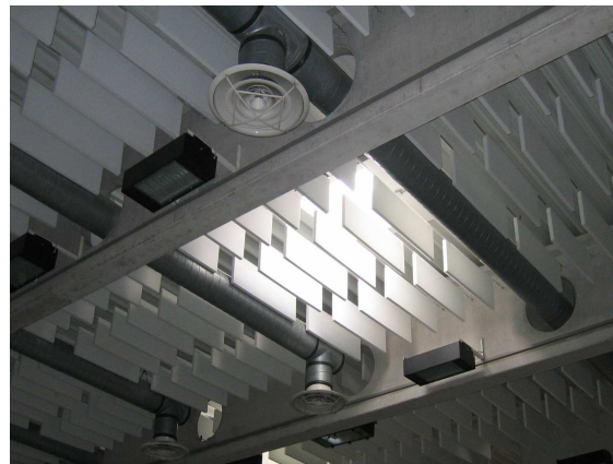
Bild: An Drähten hängende Absorberplatten
