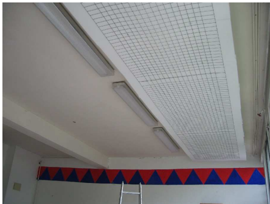
Bild: Melaminharzschaumstoffplatten auf abgehängten Armierungsgittern
